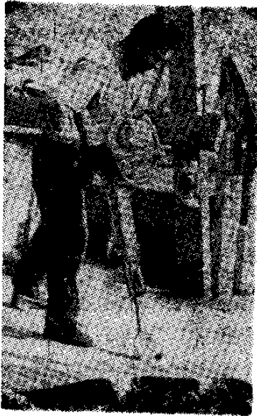
Sl. 8.30. Motorni čekić za razbijanje asfalta i betona (Wacker Werke—München)
